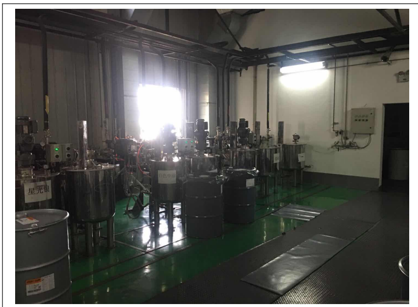
图 2-2 调漆间防渗地面
