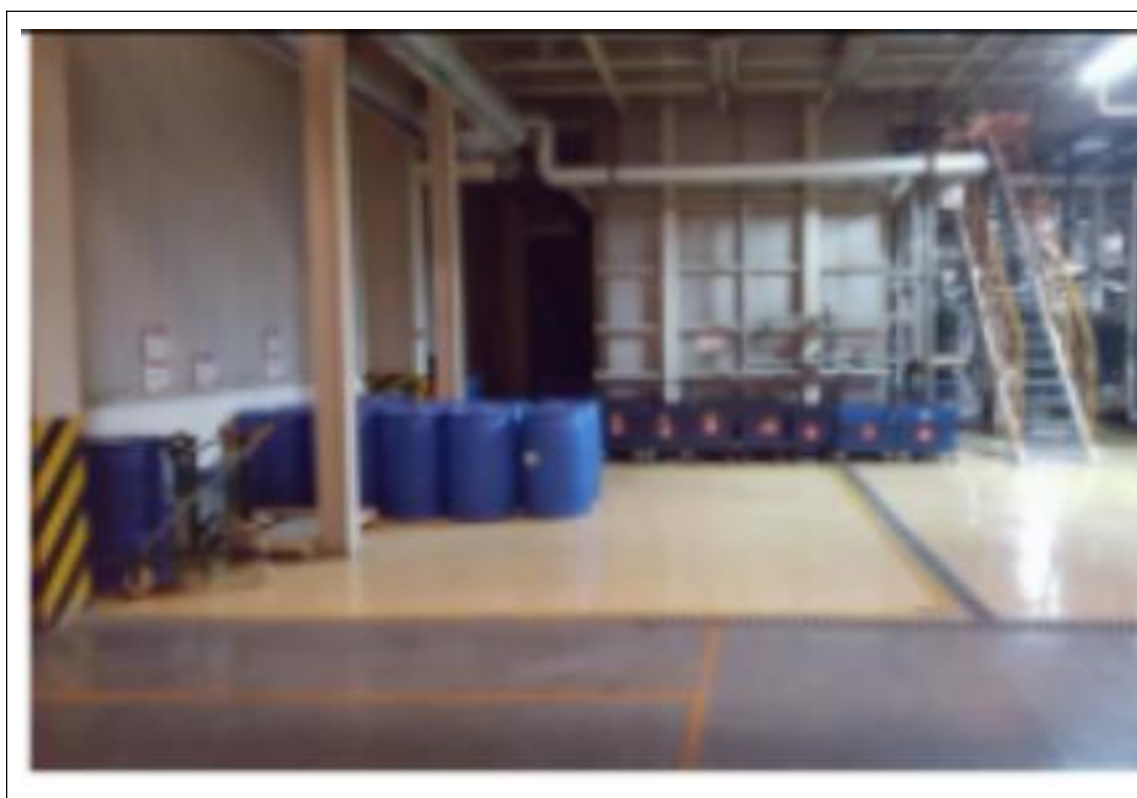
图 2-5 储存泄露收集槽
